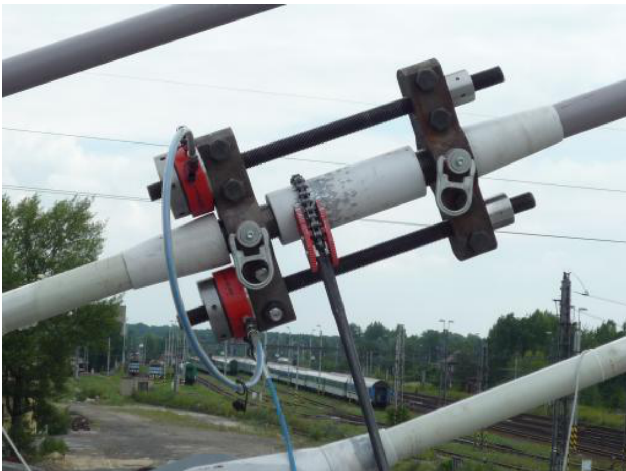
Obr.1.3 Hydraulické napínací zařízení
