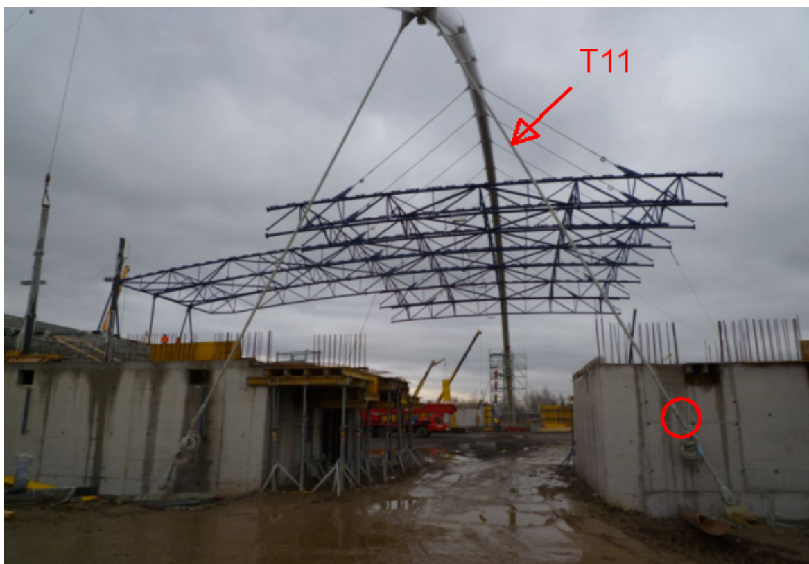
Obr.6.13 Táhlo T11 ZS Chomutov, napínáková matice označena kroužkem
