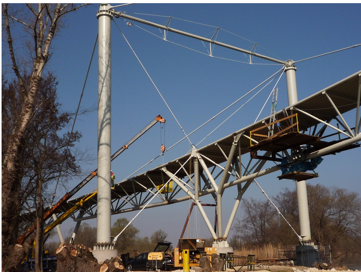
Obr. 1.1. Konstrukce s využitím předpjatých táhel
