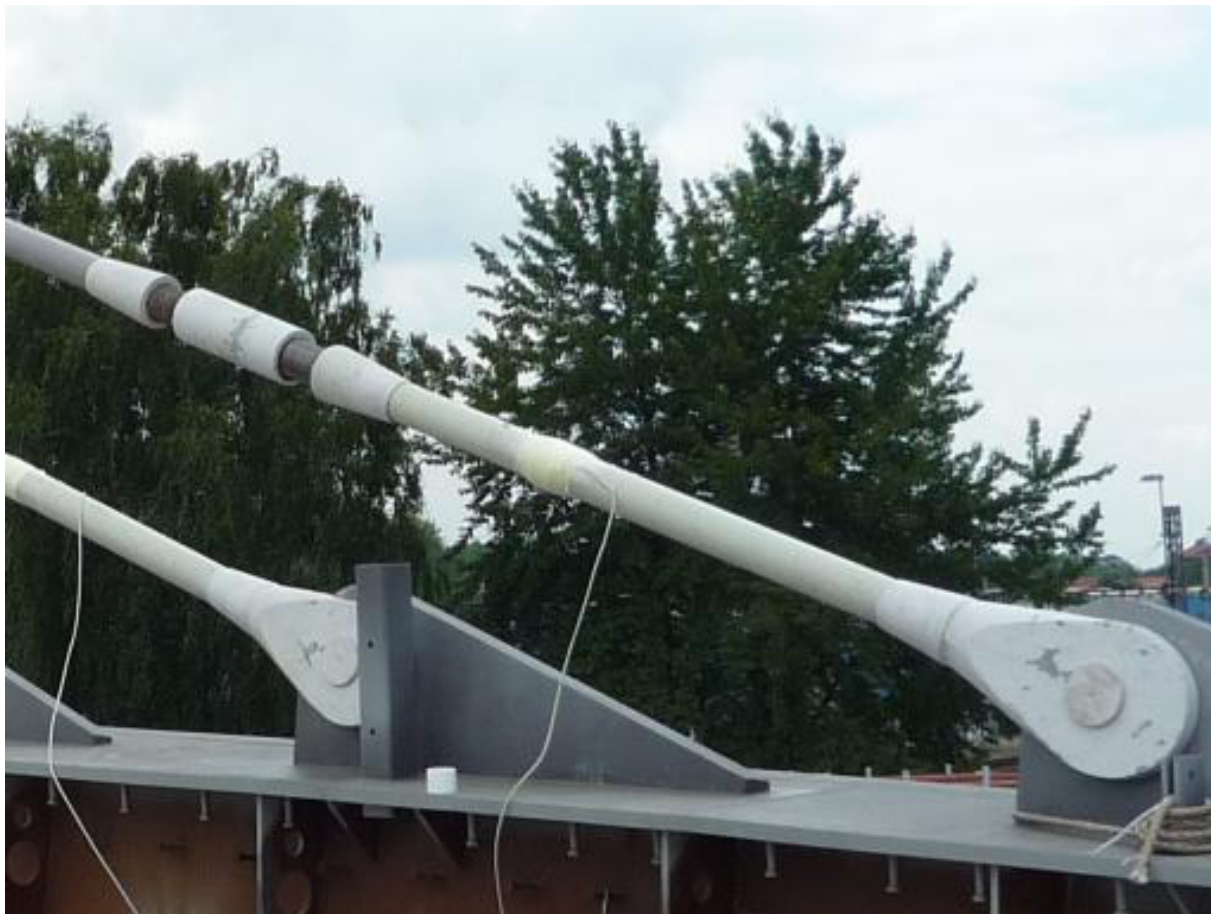
Obr 1.2 Napínáková matice a koncovka s čepem
