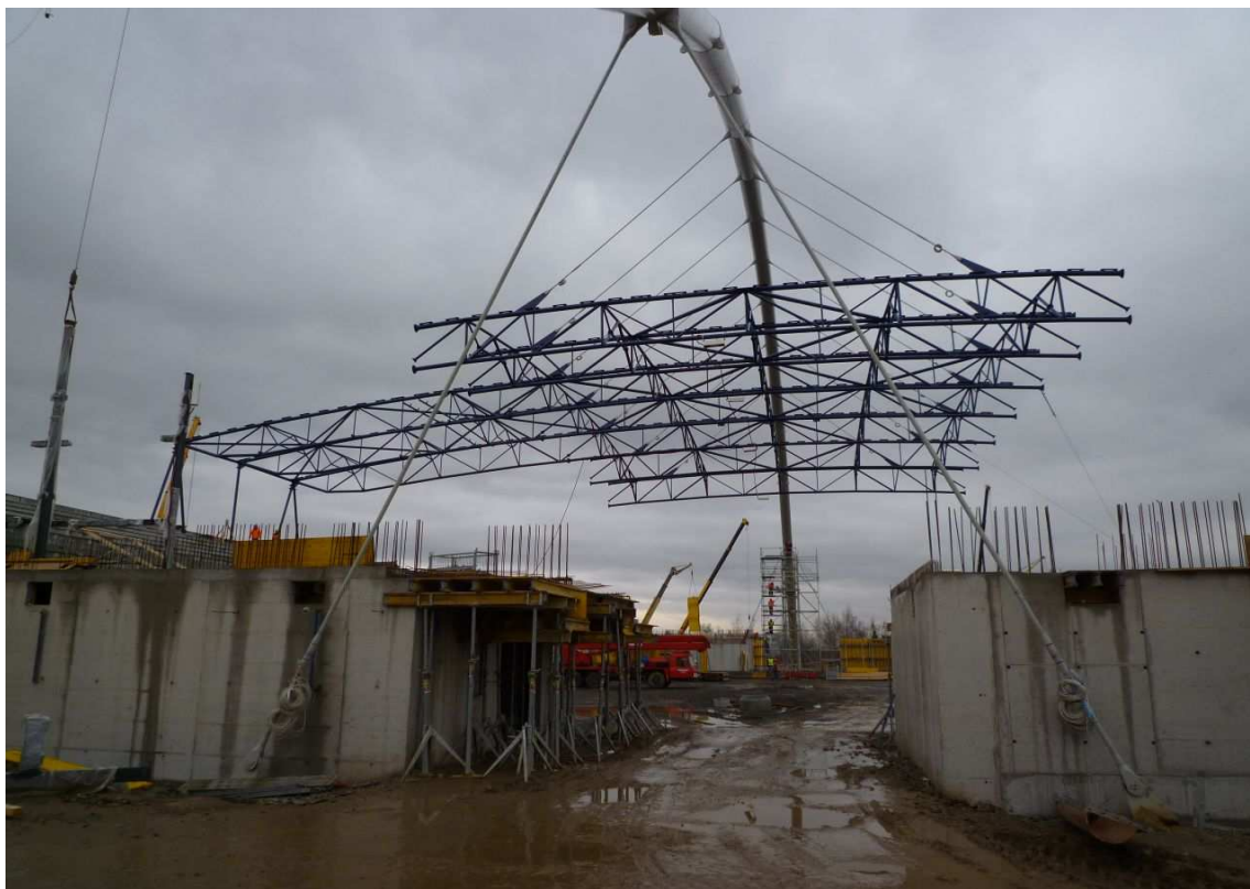
Obr. 1.1. Konstrukce s využitím předpjatých táhel
